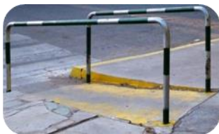
Figura 21: Barandas de rampa para acceso a plaza Desamparados. Fuente: Relevamiento fotográfico propio del mobiliario urbano de espacios públicos del Gran San Juan.
